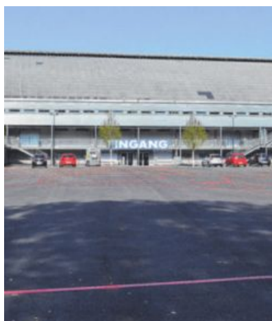
Mit den Stadtwerken Feldkirch wurde ein Konzept für die Anlage erarbeitet. STADT
